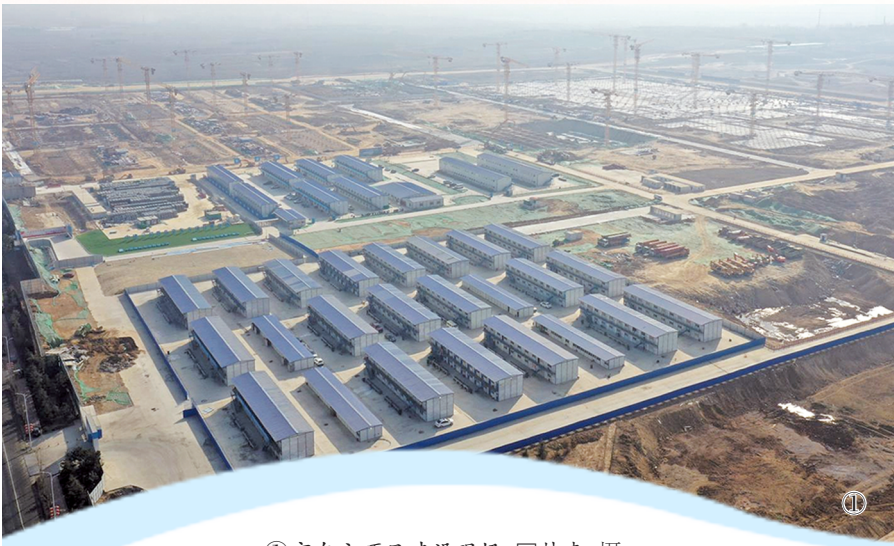
①京东方项目建设现场。□韩森 摄
