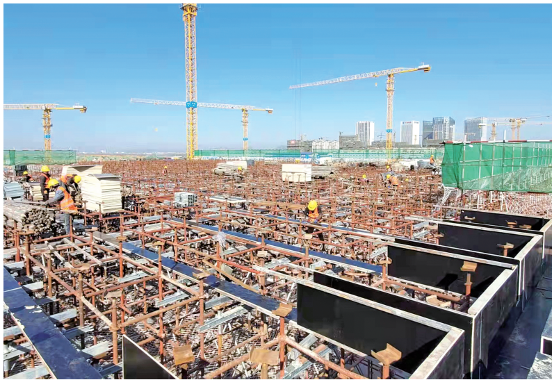
京东方物联网移动显示端口器件青岛生产基地项目施工现场。
