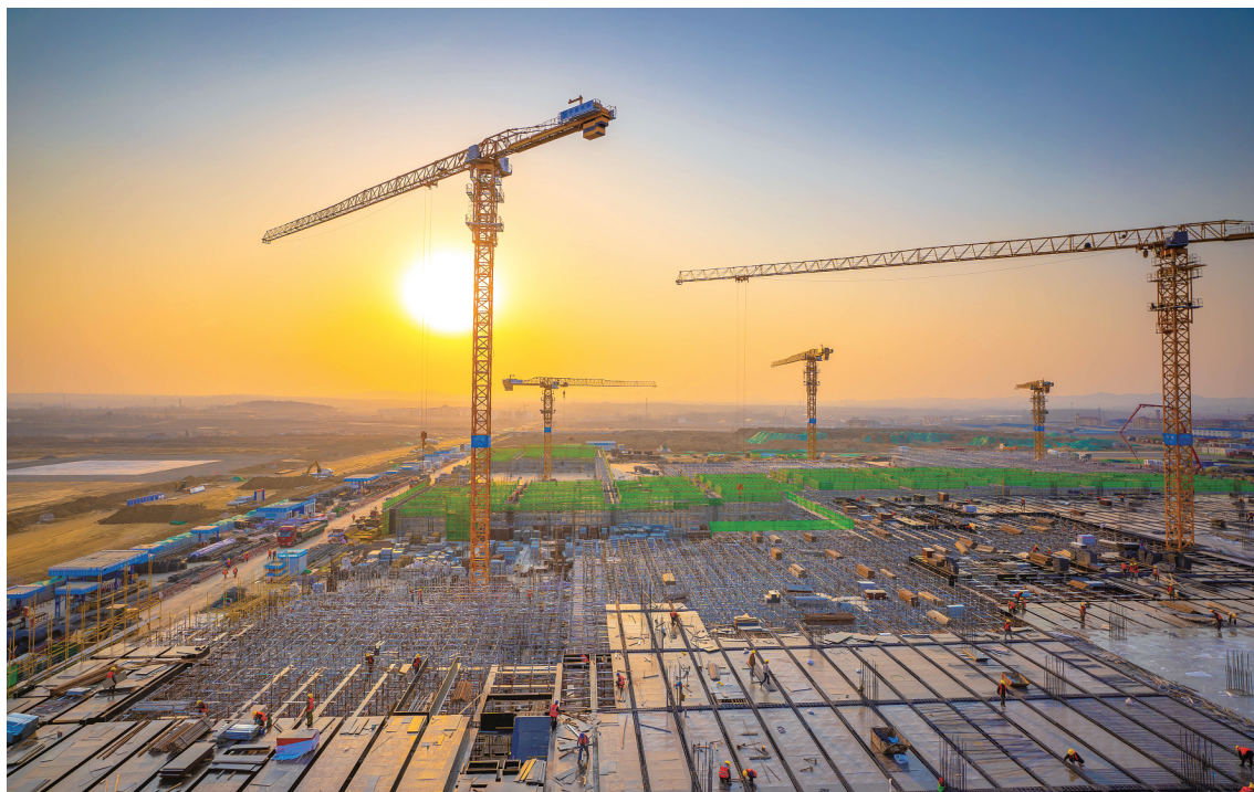
京东方项目已经实行全封闭管理机制,正紧锣密鼓进行主体施工。
