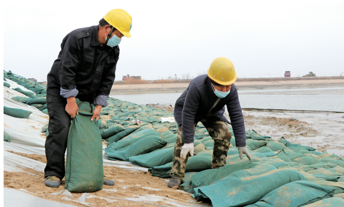
建筑工人正在进行上下游围堰沙袋施工。
