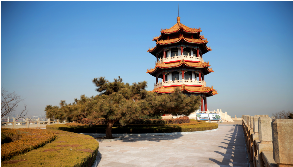
正在修缮中的北海公园主体建筑观涛阁。
