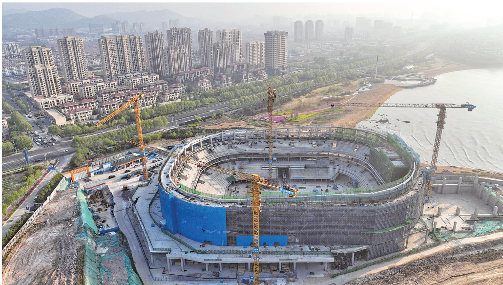
新区奥体中心体育馆项目建设现场。□记者 李亮 摄
