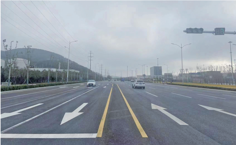
改善提升后的汉江路焕然一新。
