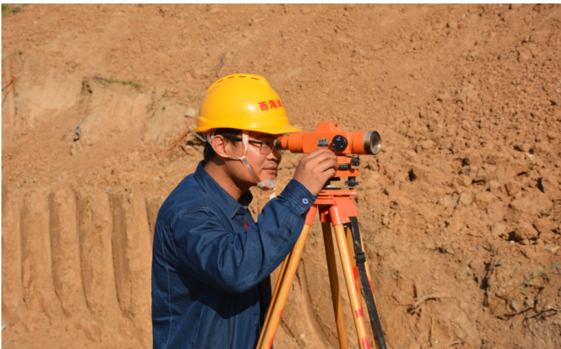
郭梦超在工程现场进行测绘。
