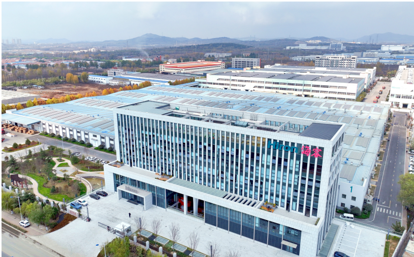
位于胶南街道的青岛海容商用冷链股份有限公司
