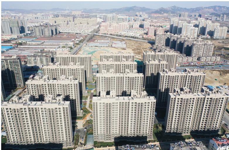
大荒庄安置区建有12栋高层住宅楼。
