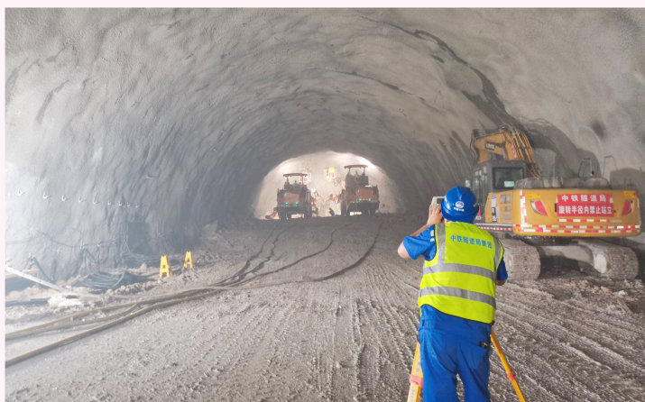
两台三臂凿岩台车正在进行开挖钻孔作业。
