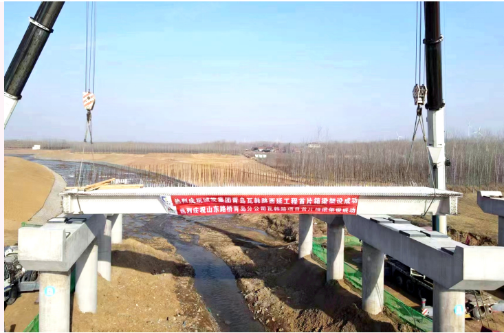
瓦韩路西延工程首片箱梁架设成功。
