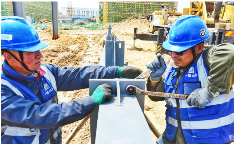
项目施工现场,工作人员正在组装大梁。□记者 陈蔚 摄
