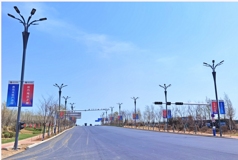
岛耳河四路施工接近完工。
