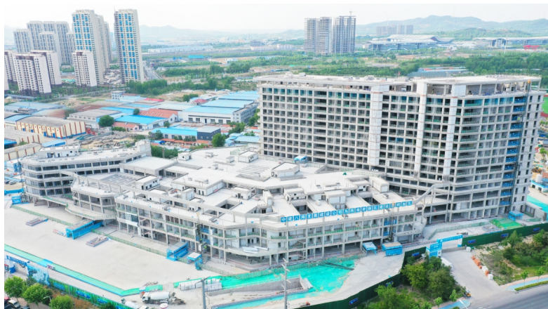
西海岸新区第二中医医院新院区预计2025年竣工并投入使用。□李健 摄
