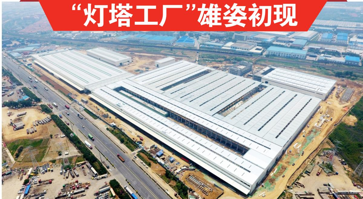
近日,位于西海岸新区的潍柴(青岛)智慧重工智造中心项目封顶,厂区钢结构围护板安装完成,全面进入室内基础施工阶段。据了解,作为潍柴全力打造的“灯塔工厂”以及全球智造中心,该项目将来主要生产最新一代智慧工程机械,预计年产量约2.3万台,年销售收入逾150亿元。图为正在建设中的潍柴(青岛)智慧重工智造中心项目(6月6日摄,无人机照片)。
