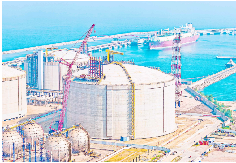
国内最大容积LNG储罐在新区机械完工。
