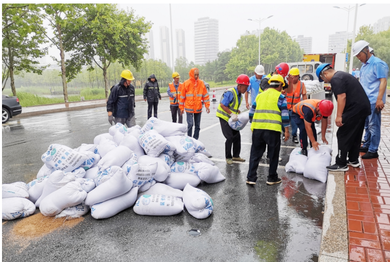
工作人员在防汛演练中对“故障点”进行抢修。
