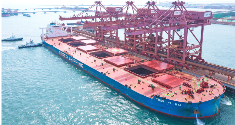
“远谊海”轮在山东港口青岛港董家口港区完成矿石卸船作业。
