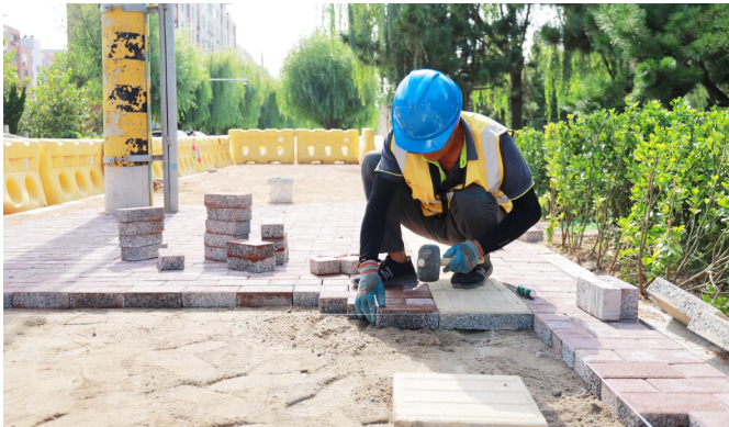
工作人员重新铺装人行道板。
