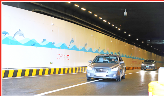
珠江路隧道内景 □记者 张静 摄
