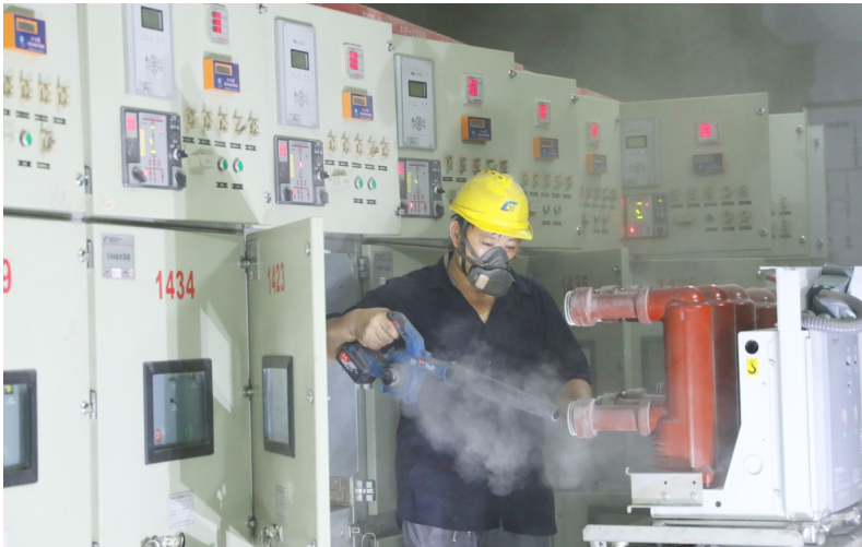
供热工人清理配电室里的高压配电柜积灰。
