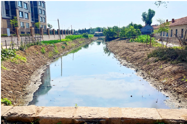
佳苑小区南门河渠整治工作初见成效。
