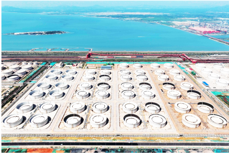
董家口港区原油商业储备库项目全面建成投产。
