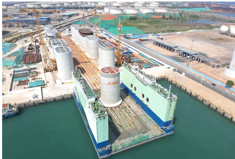
董家口港区第二座40万吨级矿石码头首座沉箱完成安装。
