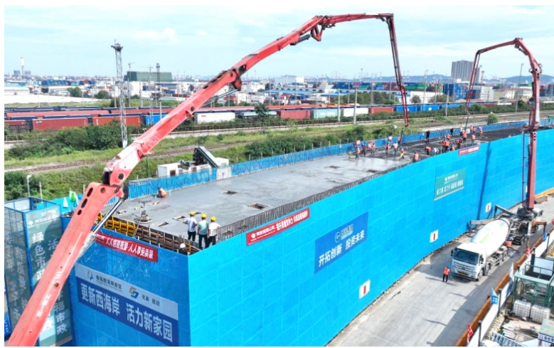
疏港高架拓宽工程西接疏港高速匝道板块首联箱梁浇筑施工现场
