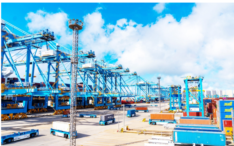
山东港口青岛港前湾港区自动化码头“双节”期间生产繁忙。
