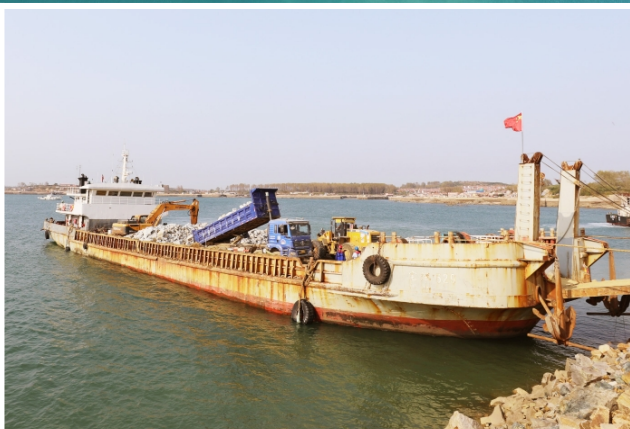
▲从空中俯瞰国家骨干冷链物流基地防波堤工程施工现场。 ▼运石车将碎石运至抛石船。□记者 董梅雪 摄
