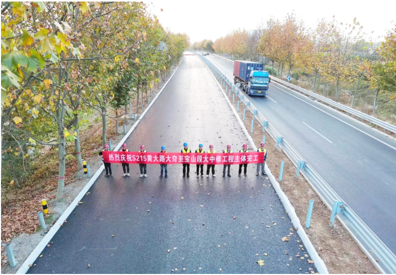
黄大路大乔至宝山段大中修工程主体完工。
