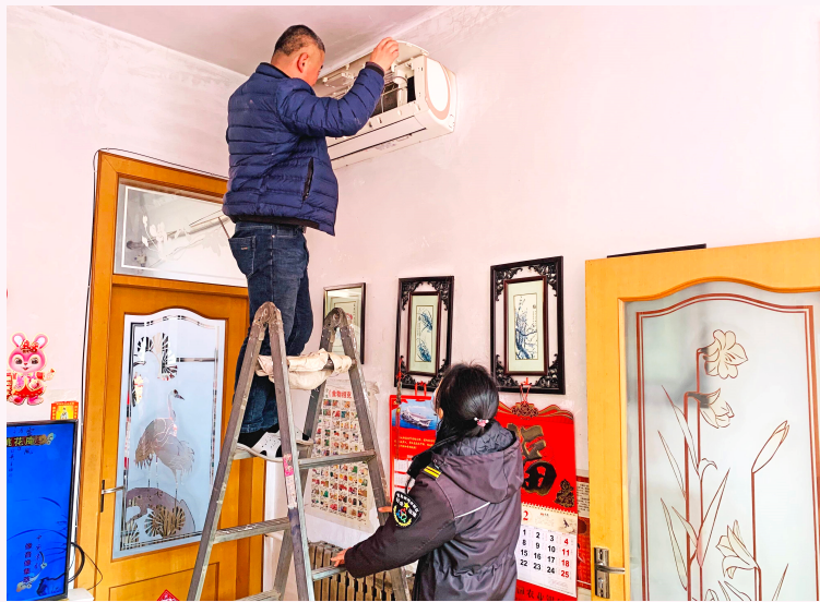
丙村第一微网格工作人员入户帮助村民维修空调。
