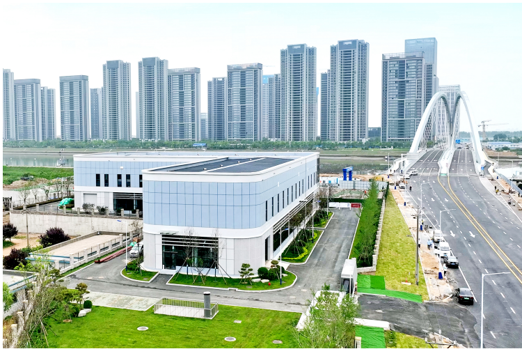
华能热力出线项目海洋活力区泵站
