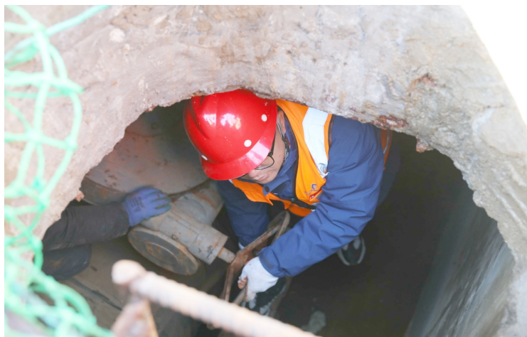
能源公司供热人员检查维修供热管线。
