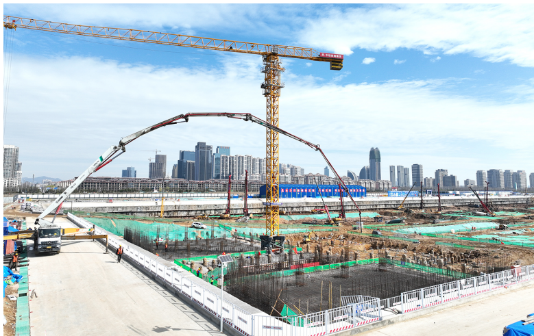
青岛风河生态运动公园项目施工现场一派繁忙景象。
