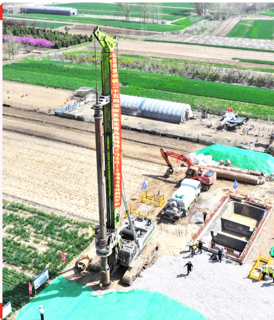
4月16日,潍宿高铁至青岛连接线工程首桩开钻。
