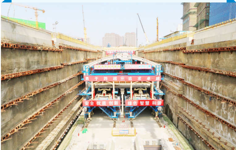
装配式车站拼装现场
