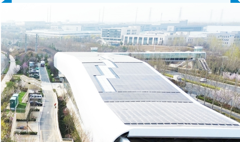
6号线一期在横云山路站设置的屋面光伏系统
