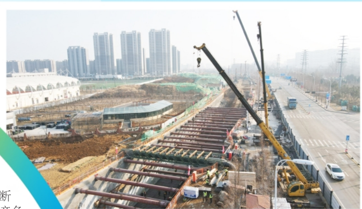
▲青岛市城市更新建设重点攻坚项目——三沙路综合管廊项目
