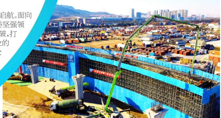
▲省重点基础设施项目——淮河路高架桥首联梁体混凝土成功浇筑。
