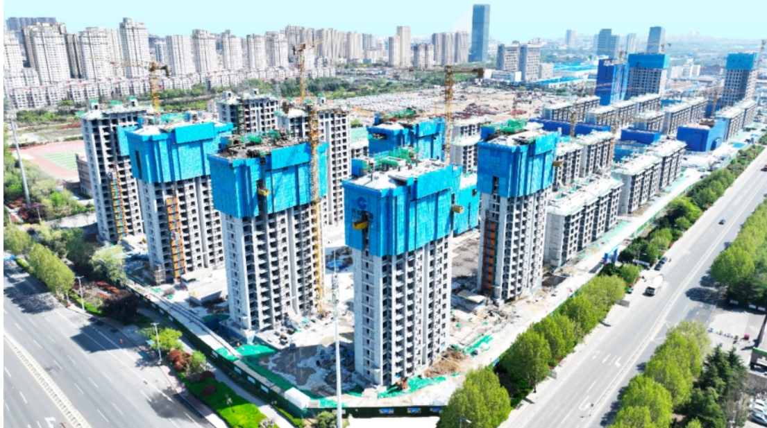
港头臧、牛王庙安置区一期31栋楼已全部主体封顶。
