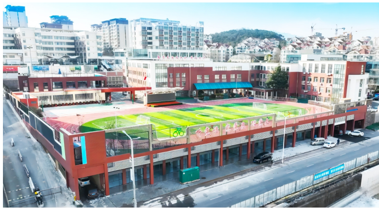
太行山路小学停车场项目有效缓解了学校周边停车难问题。
