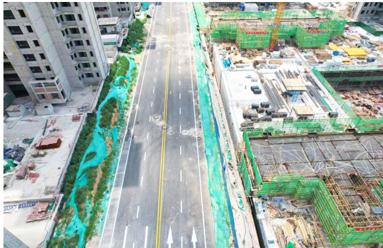
镜台山路北延道路及管网工程正加速推进。
