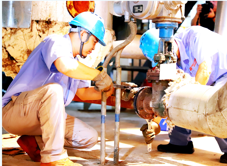
在高压加热器检修现场，工人们紧张忙碌。
