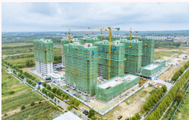
董家口化工园区拓区搬迁安置项目预计2026年完工。
