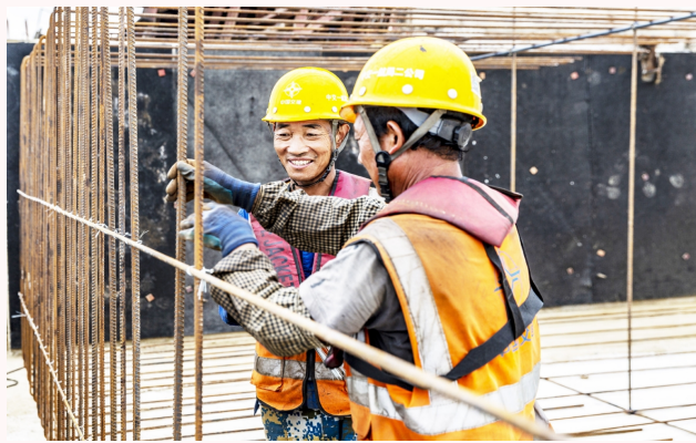
在国家骨干冷链物流基地防波堤工程建设现场,工人加紧施工。
