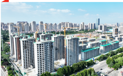
▲港头臧-牛王庙拆迁改造项目预计今年竣工、明年回迁。
