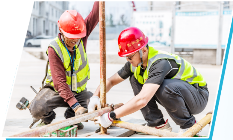
架子工进行实操考核。
