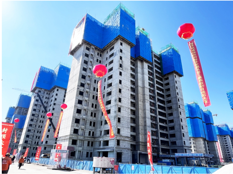
珠海街道长安路片区改造项目(二期)主体结构全面封顶。□记者 董梅雪 摄
