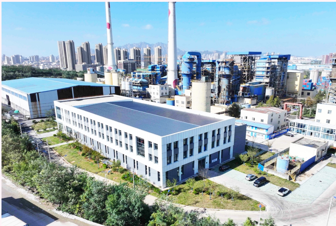
大唐热力出线项目经过全面联调联试,于今冬供热季正式投用。
