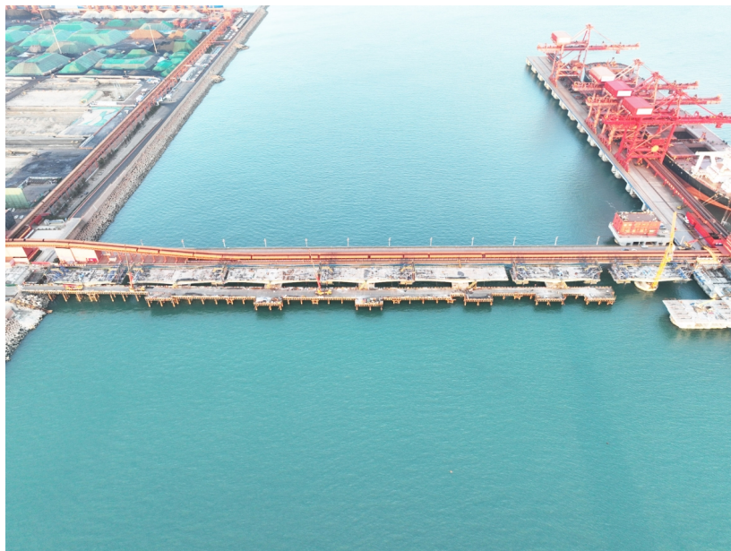
山东港口青岛港董家口港区第二座40万吨级矿石码头引桥首段成功合龙。
