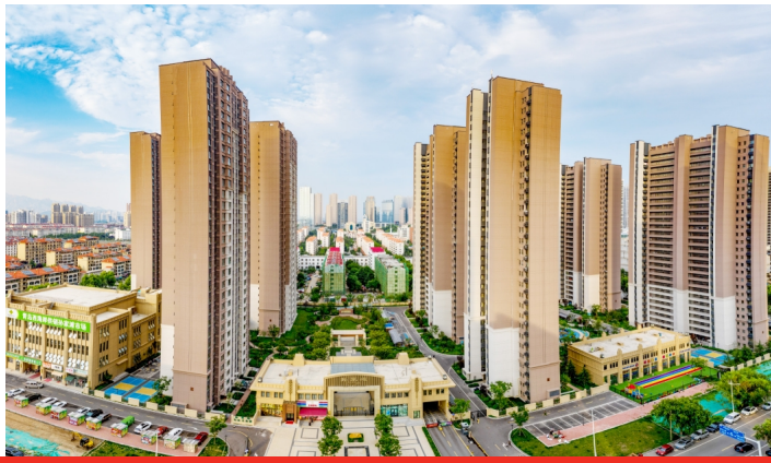
「广厦奖」的旧村改造项目。 孙家滩安置区是山东首个获
