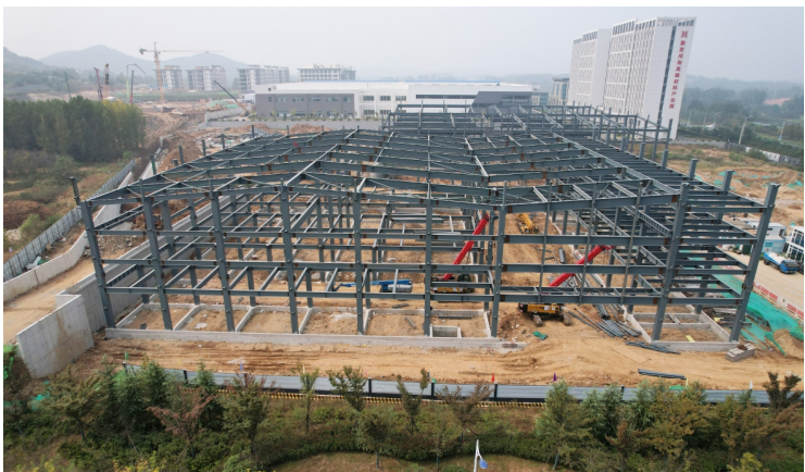
▲ 蔚蓝空间飞行器产业基地正在如火如荼地建设中。
