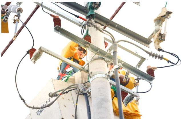
▲国网黄岛区供电公司带电作业班工作人员在10千伏长山线进行带电引流线作业,在保证周边居民用电无感的情况下为企业快速完成送电。
