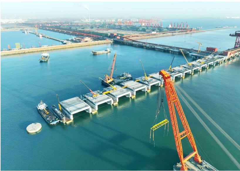
山东港口青岛港董家口港区第二座40万吨级矿石码头建设快速推进。
