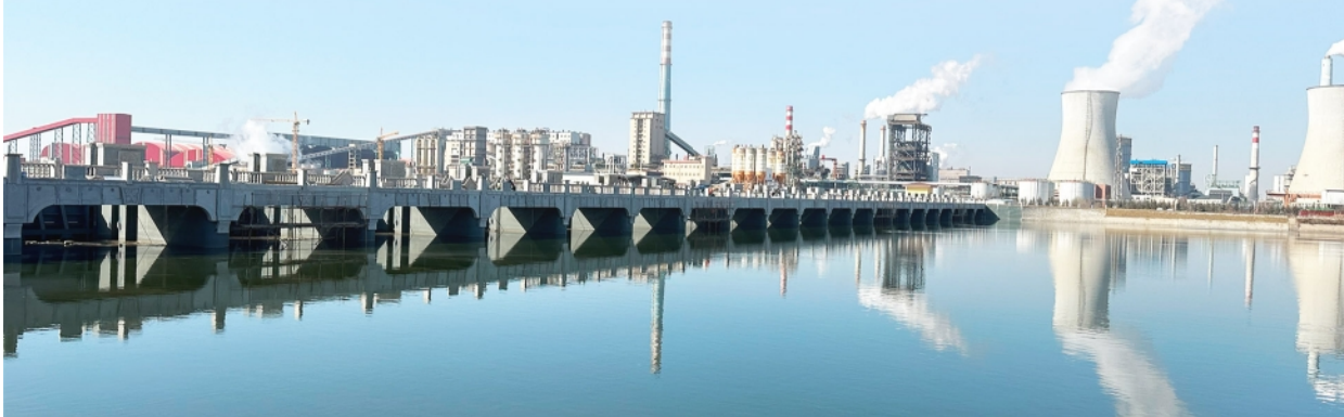
董家口经济区新建拦河闸,确保事故废水不出园区、不入海。
